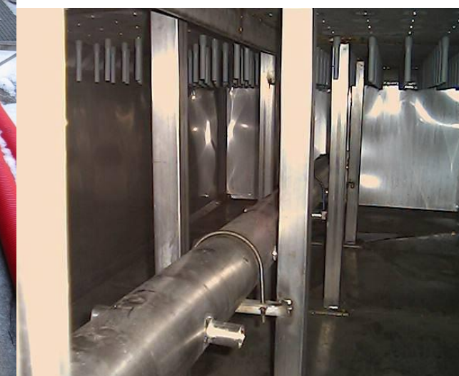
Impianto di filtrazione e decantazione acqua potabile per l'acquedotto di Lodrino (SVIZZERA) AISI 304/304L (Della Cagnoletta)
