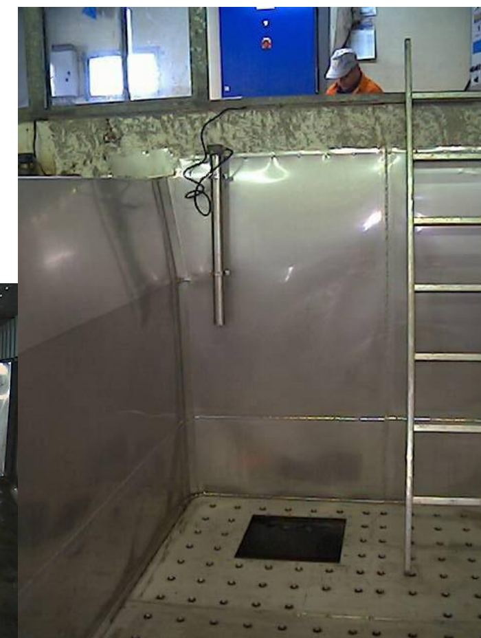
Impianto di filtrazione e decantazione acqua potabile per l'acquedotto di Lodrino (SVIZZERA) AISI 304/304L (Della Cagnoletta)
