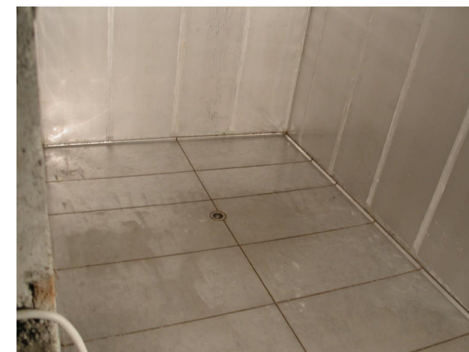
Serbatoio di accumulo dell'acquedotto di Livigno (SO) AISI 304, lamiera di sp. 1,5 mm (C.d.I.)
