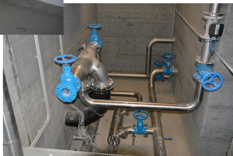
Potenziamento dell'acquedotto di Sarre (AO) AISI 304, sp. 2 mm (SOGEA)
