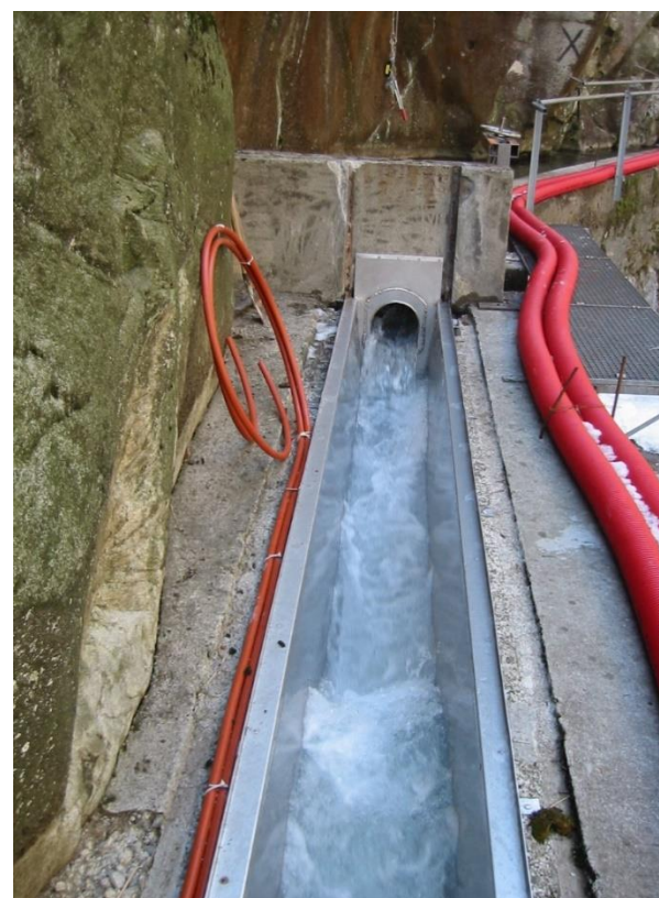
Impianto di filtrazione e decantazione acqua potabile per l'acquedotto di Lodrino (SVIZZERA) AISI 304/304L (Della Cagnoletta)
